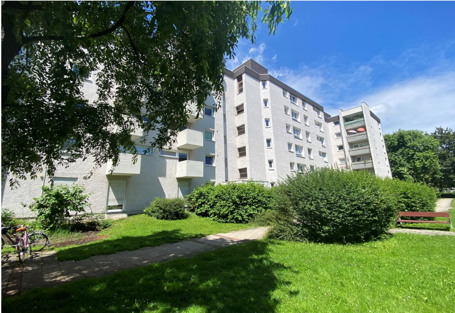
Ostansicht des Gebäudes
